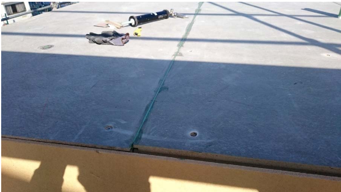
Bild 4: Dauerelastisches Abdichten der Plattenstöße.
