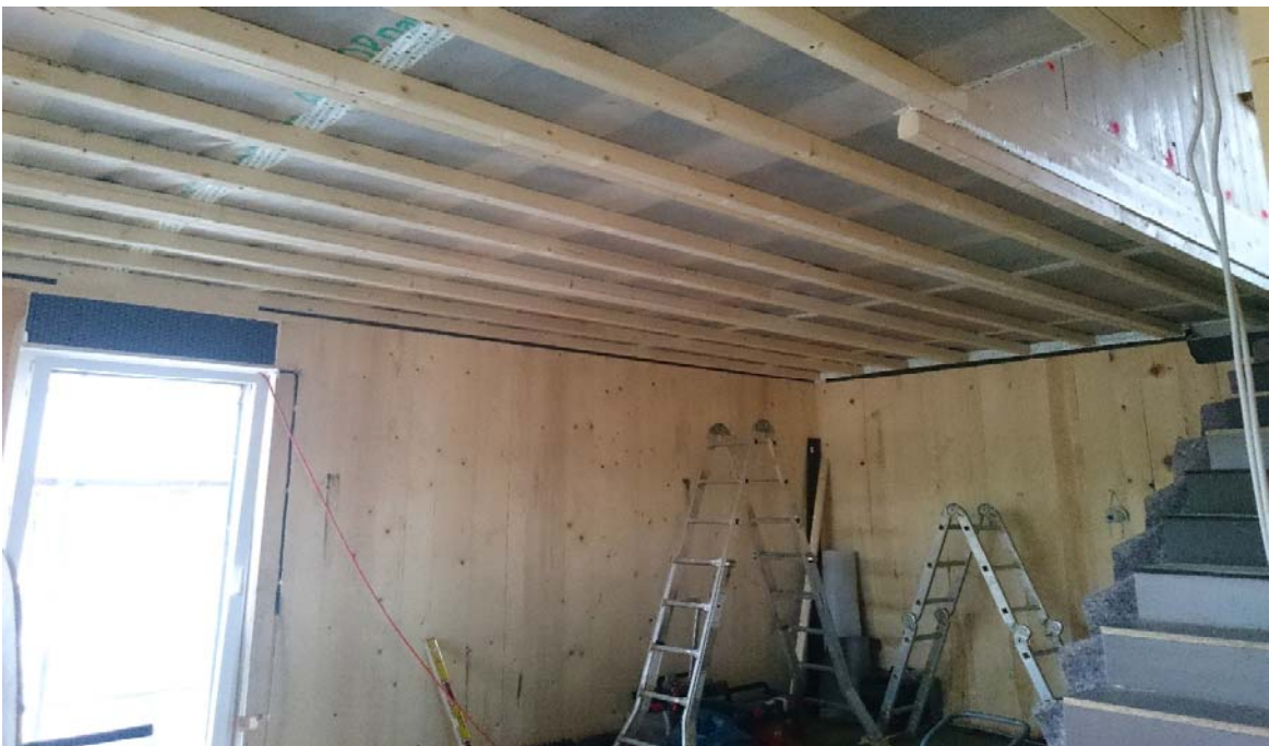
Bild 8: Konterlattung der Deckenbalken vor dem Einblasen.
