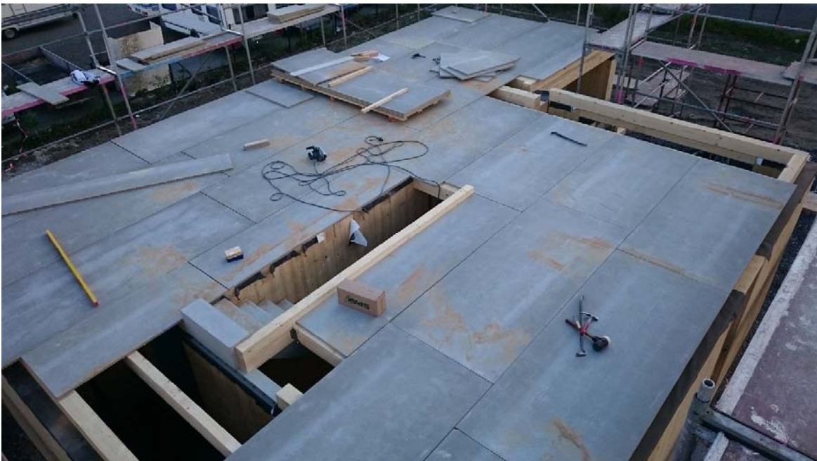
Bild 2: Die Meisten Platten sind bereits verlegt.
