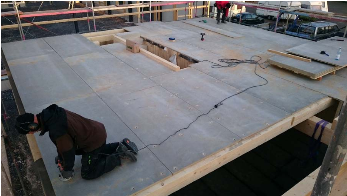
Bild 3: Einfräsen der Vertiefung für die Tellerkopfschraube
