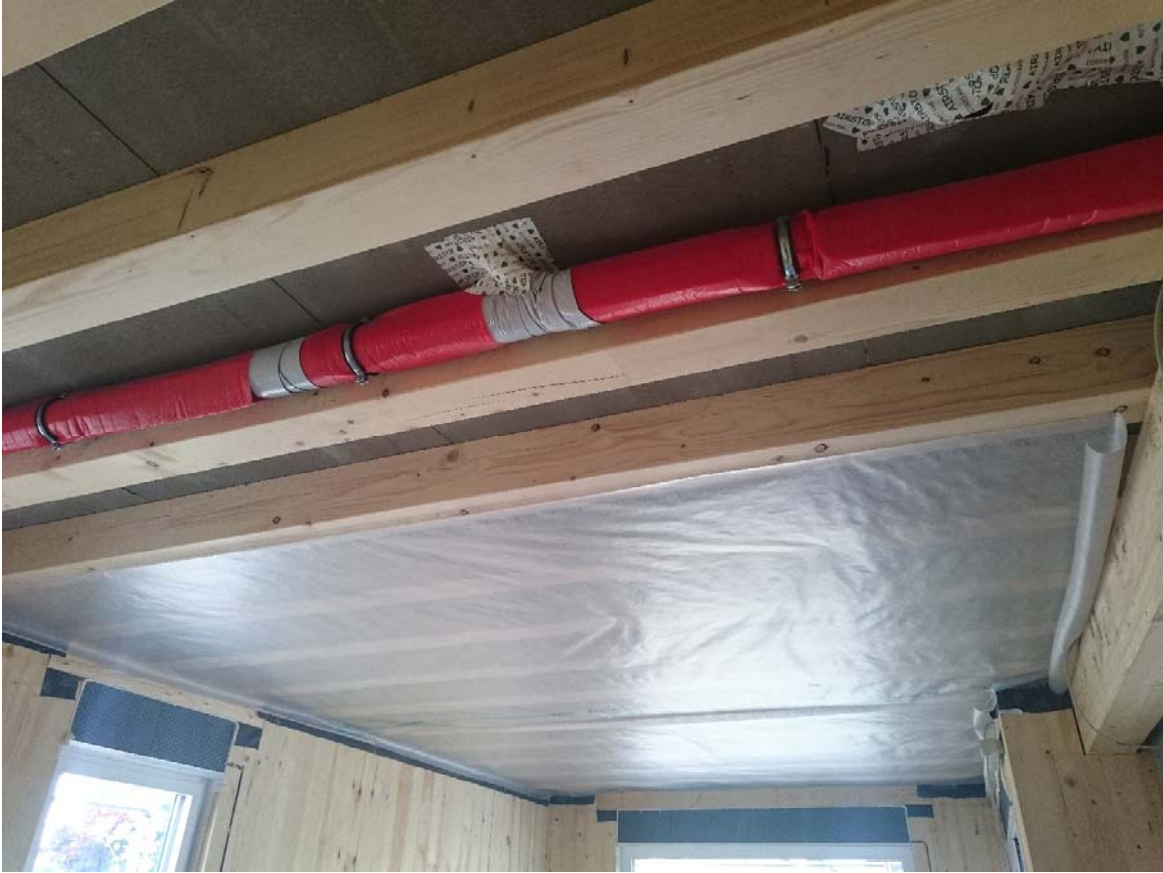
Bild 7: Nutzung der Balkenhöhe für die Verlegung der Haustechnik. Im Hintergrund die Folie für die Celluloseschalldämmung mit IsoCell.
