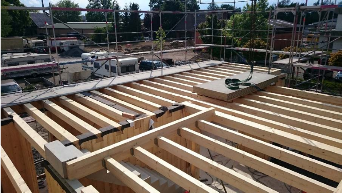
Bild 1: Beginn der Verlegung der Cetrissplatten auf der Holzbalkenlage
